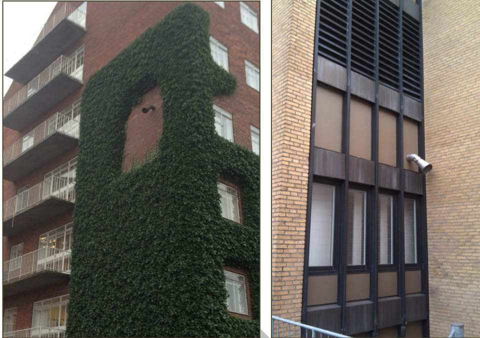
Figur 7: Eksempler på quench-rør i facaden, Aarhus Universitets Hospital og Regionshospitalet Viborg.
