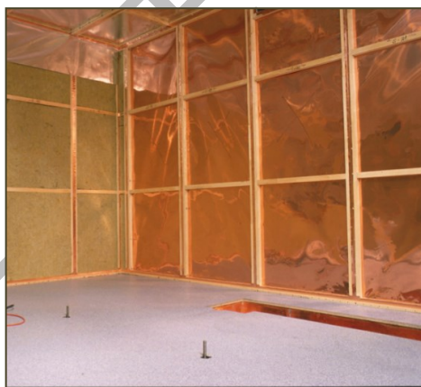
Figur 9: Foto af Faraday-bur ved placering i rårum.
