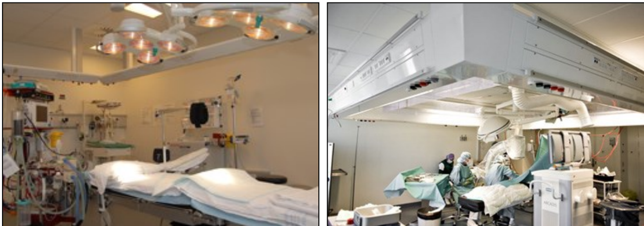
Figur 18: Loftmonteret bro, hhv. Hospitalsenhed Midt og Rigshospitalet Glostrup
