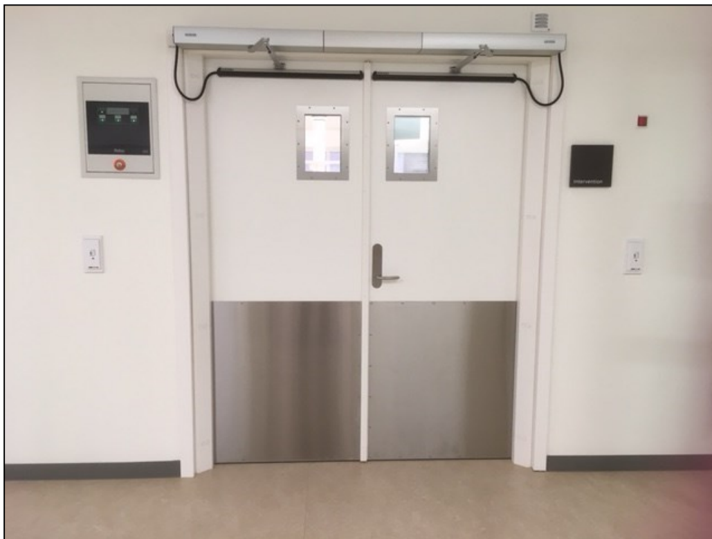
Figur 8: Eksempel på to-fløjet dør, hvor hver fløj kan åbnes enkeltvis men også samlet, Aarhus Universitetshospital
