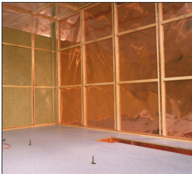
Figur 9: Foto af Faraday-bur ved placering i rårum.
