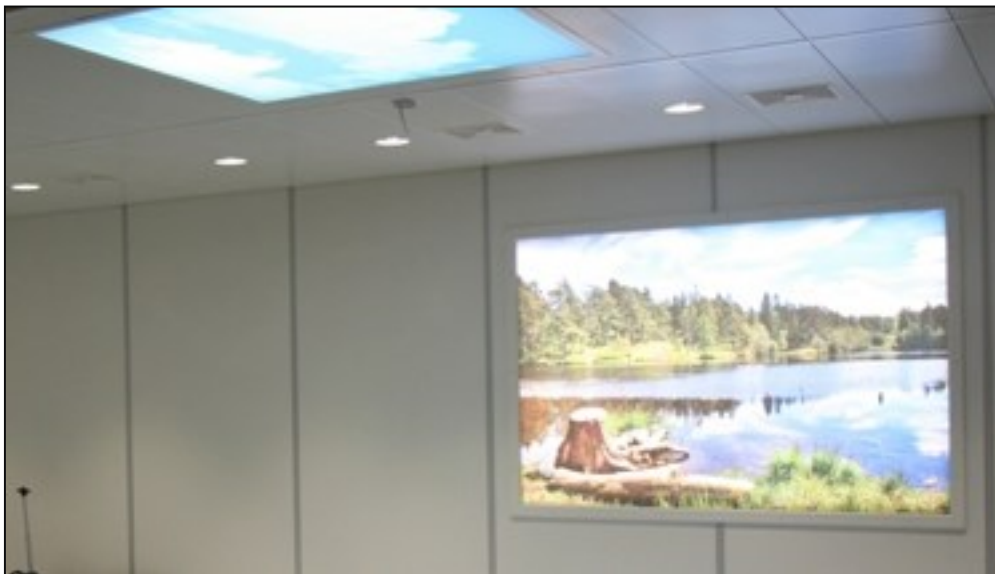
Figur 4: Eksempel på integreret kunstigt ovenlys og vindue i MR-skannerrum på Bornholms Hospital. Kilde: www.bornholmshospital.dk
